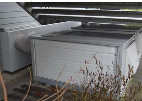
Foto 2: De technische ruimte van de parkeergarage wordt op temperatuur gehouden door pcm-koelers van Tizzin. Wordt de temperatuur te hoog, dan smelten de pcm's en nemen daarbij warmte op. De afgekoelde lucht wordt dan naar binnen geblazen.
